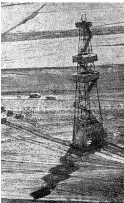
Красноярский участок нефтепромыслового управления «Бугурусланнефть». Передвижение буровой вышки тракторами.
